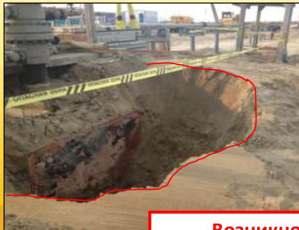
Формирование области оттаивания многолетнемерзлых пород (ММП) в процессе эксплуатации добычных скважин на кустовых площадках НГ месторождений
