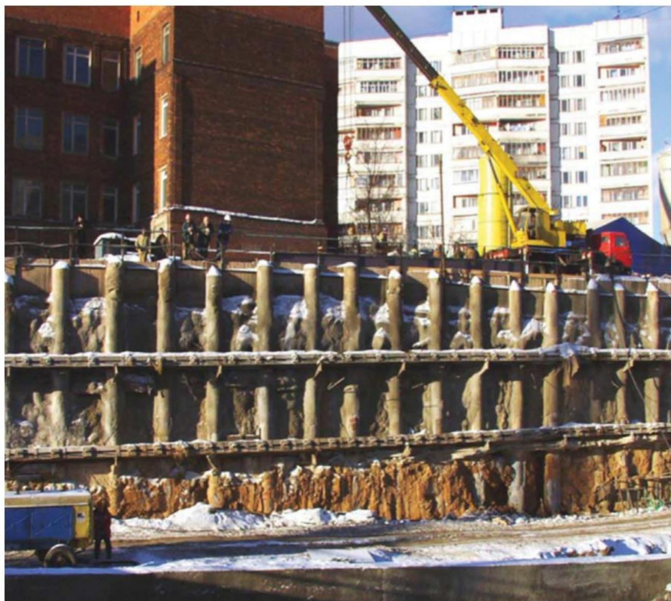
**Рис. 2. Пример использования комбинированной ограждающей конструкции**
